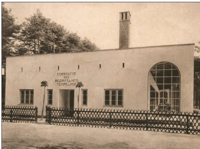
Die vom Hochbauamt Berlin Tempelhof 1929 erbaute Kurstätte für tuberkulose gefährdete Kinder, heute eine vom Wald überwucherte Ruine.
